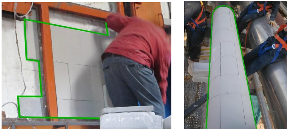
(a) 15 吨链条燃煤锅炉改造
